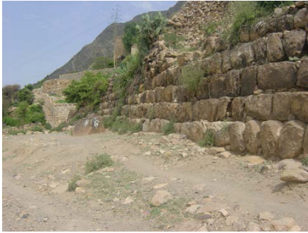
لوحة (٢٦) طريقة ارتداد المداميك للخلف في بناء السور - موقع حَرْب
