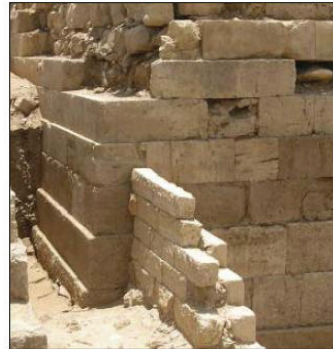
لوحة (٢٧): طريقة ارتداد المداميك في معبد ودم ذو مسمم (عن حنشور، الخصائص المعمارية، ص ١٣)
