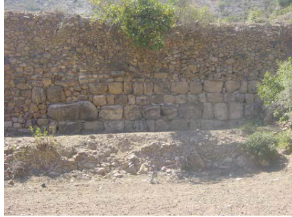
لوحة (٢٩): أحجار مهندمة منقولة من سور المدينة، أعيد استخدامها في بناء أحد الحقول في الجهة الشمالية - موقع خَرْب
